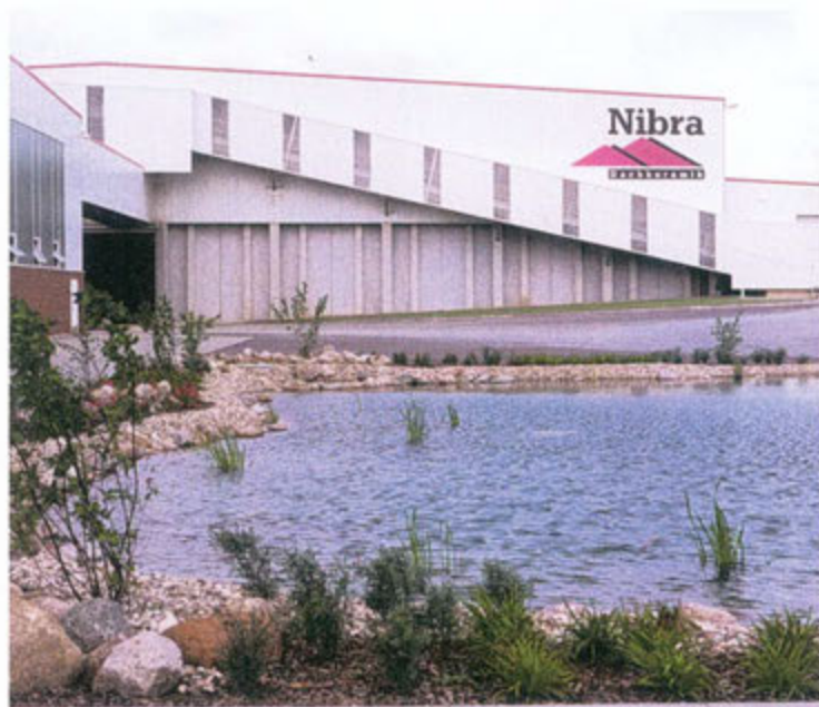
Produktionsstandort für Dachziegel: Nibra Dachkeramik in Groß Ammensleben
