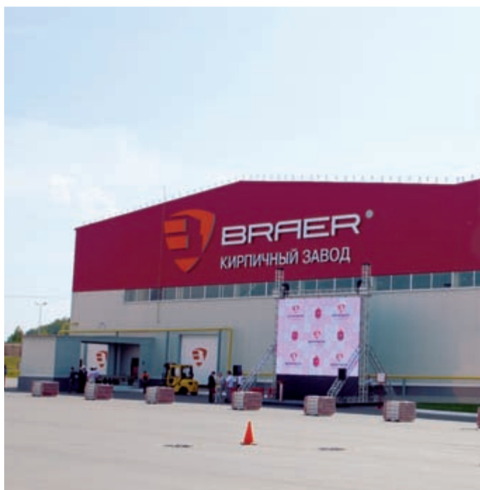
Produktionshalle des Ziegelwerks
