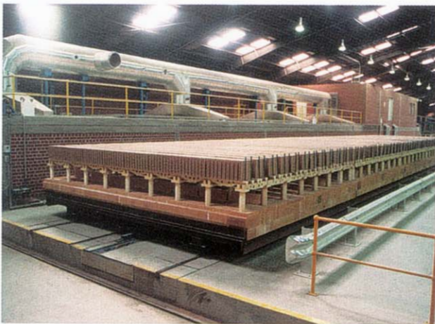
Gesetzte Ofenwagen vor dem Nassspeicher mit aufgesetzter Schaltwarte Set kiln car in front of the wet store with attached control room
