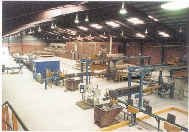
Die Spaltplatten-Produktionsanlage mit dem zentral angeordneten Bedienpult ist überschaubar konzipiert The split tile production plant with the centrally positioned operating panel is designed to be easily surveyed
