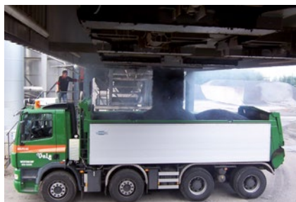
Асфальтовые и бетонные заводы
