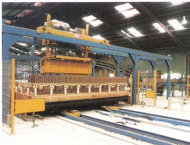
Die Spaltplatten werden mit dem Entladegreifer abgehoben The split tiles are lifted off with the unloading gripper
