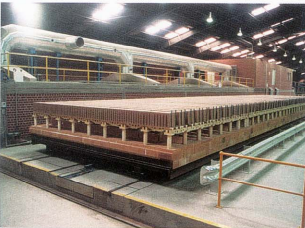
Gesetzte Ofenwagen vor dem Nassspeicher mit aufgesetzter Schaltwarte Set kiln car in front of the wet store with attached control room
