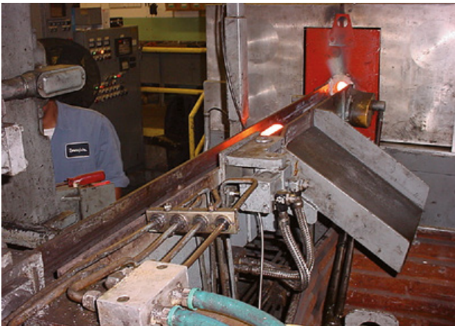
Bild 1 Schleuse zum Aussortieren der Blöcke mit zu niedriger oder hoher Temperatur
