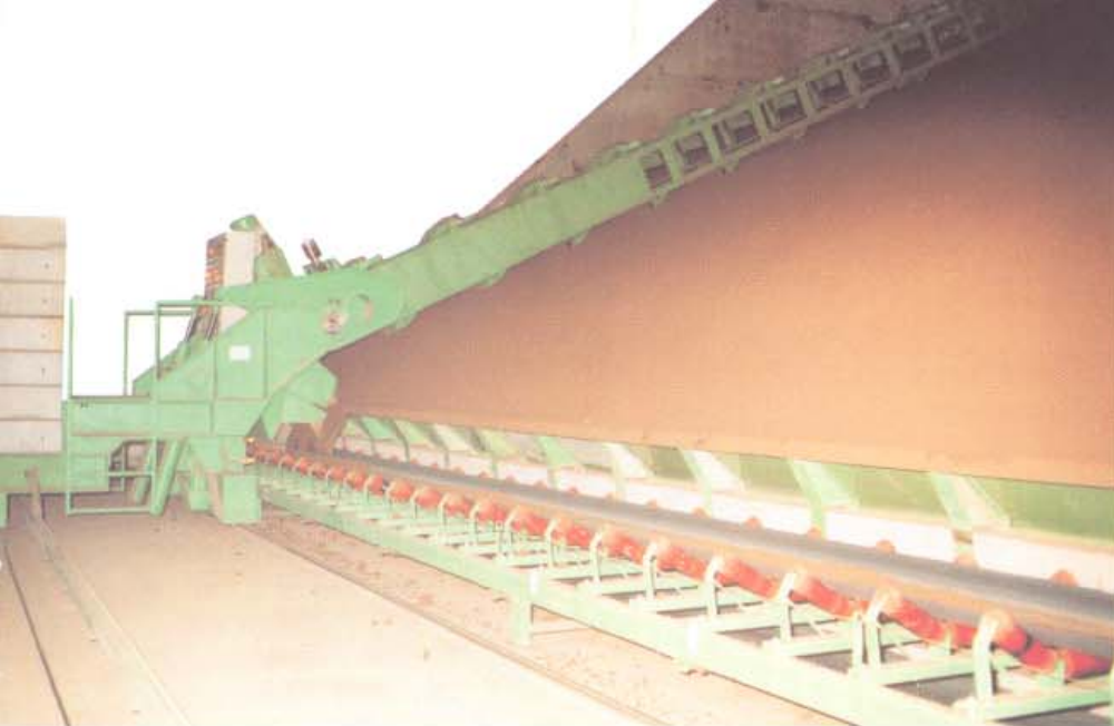
Entnahme der aufbereiteten Rohstoffe aus dem Längssilo mit einem Hänkle Eimerkettenbagger.
