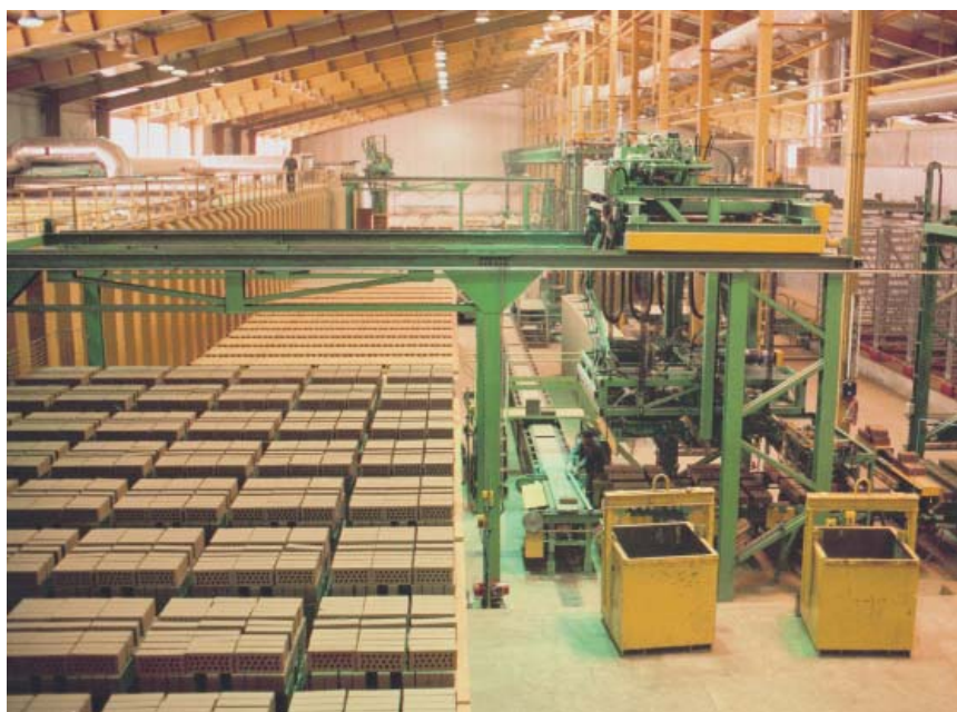
Gesamtansicht Setzmaschine Общий вид: садочная машина
