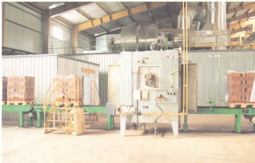
Gasbefuerter Ofen zum Einschrumpfen der Versandpakete.
