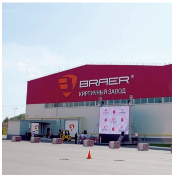
Produktionshalle des Ziegelwerks
