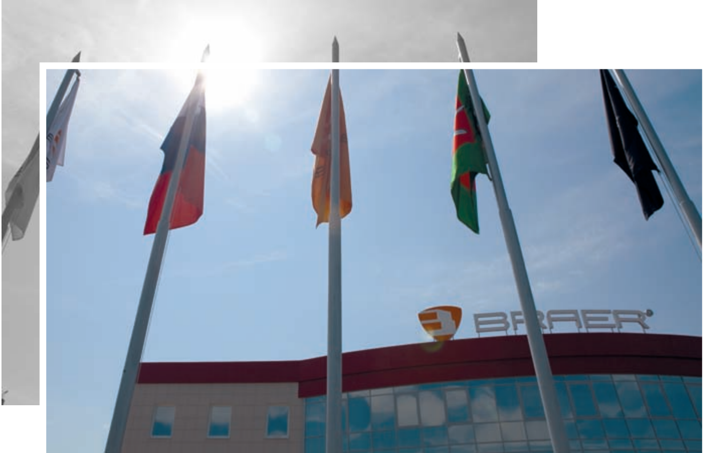
Verwaltungsgebäude des Ziegelwerks „Kipitschny zavod „Braer“
