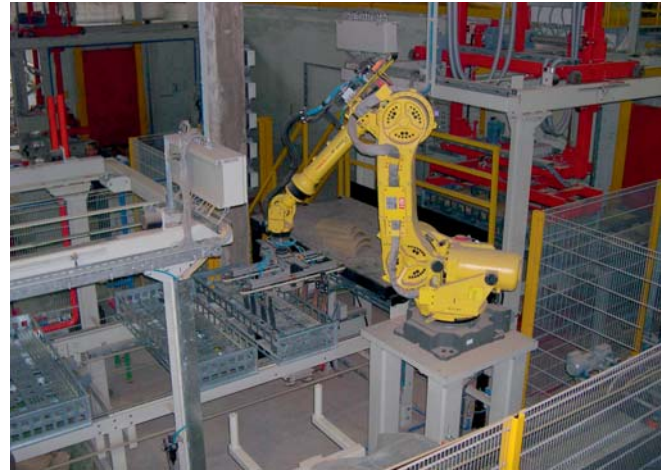
Roboter zum Entladen der Trockengutträger Robot for the unloading of drying frames
