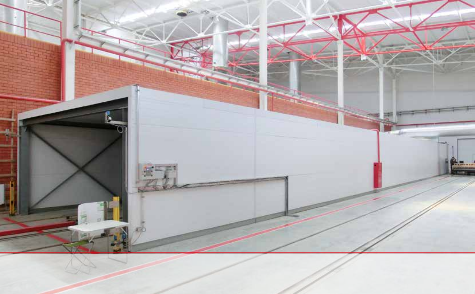
Holding room Tunnel d'attente
