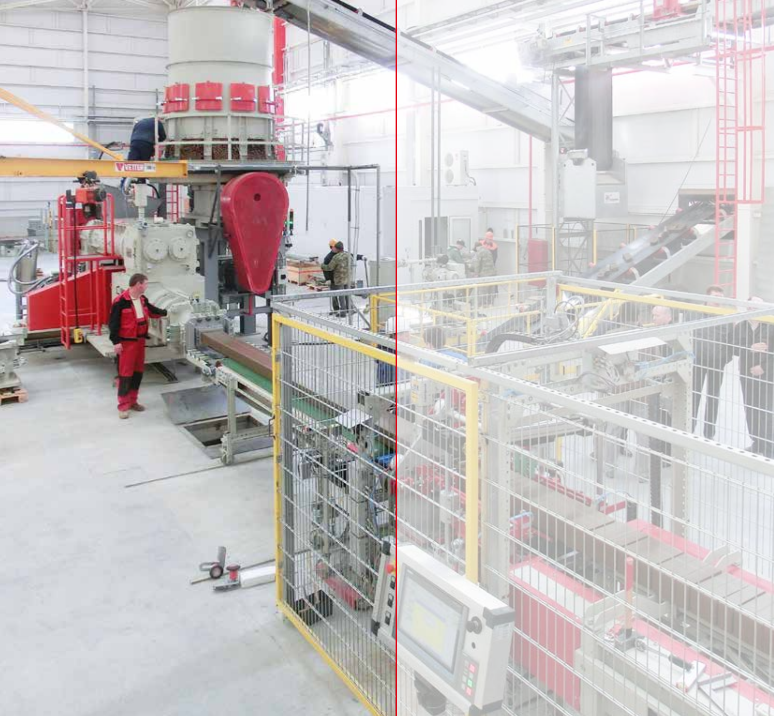
Shaping plant Installation de façonnage
