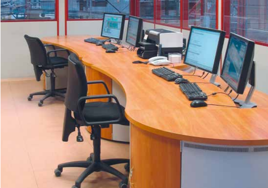
Schaltwarte Control room
