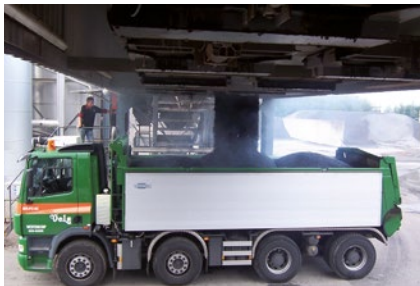
Centrale béton / asphalte
