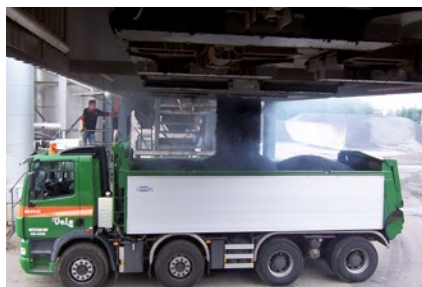
Centrale béton / asphalte
