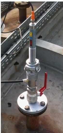
Pyromètre CellaTemp® PK avec dispositif de montage
